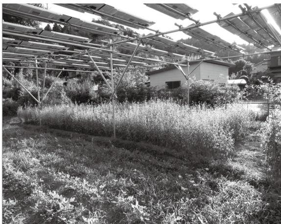
図6：個別に手動で水平に回す方式
