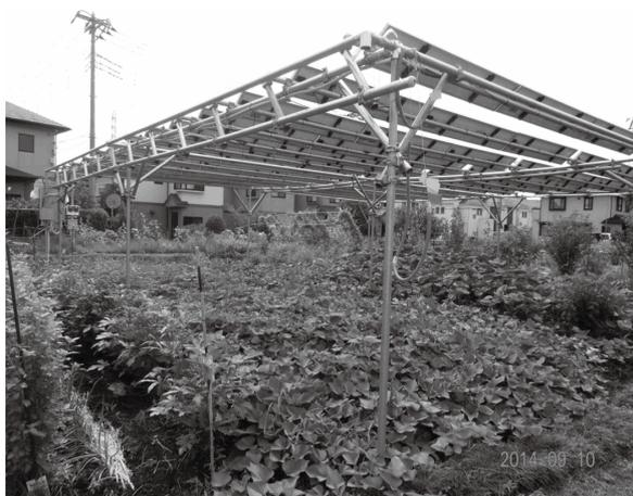
図7：全体をリンクで結合して手動で回す方式
